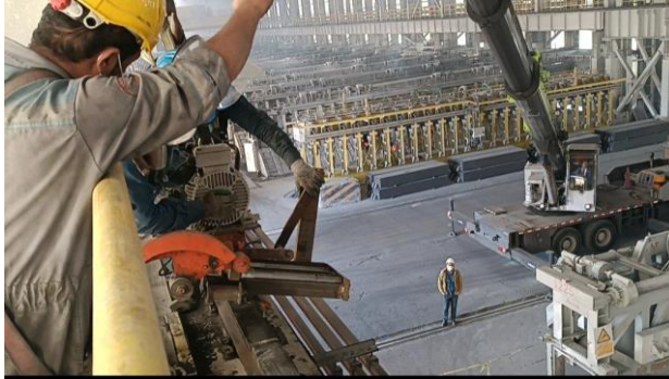
انتقال دستگاه برش ریل به نقطه شکستگی
