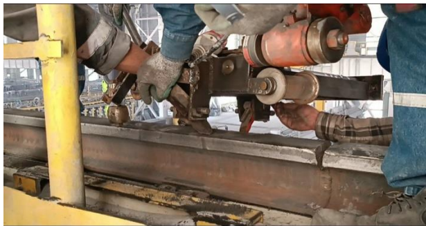
نصب دستگاه برش ریل روی ریل
