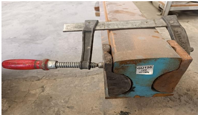
نحوه بستن قالب های مسی روی ریل
