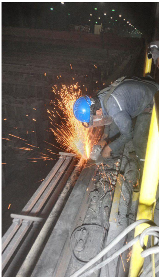
سنگ زنی در پایان جوشکاری جهت تراز کردن نقطه مد نظر
