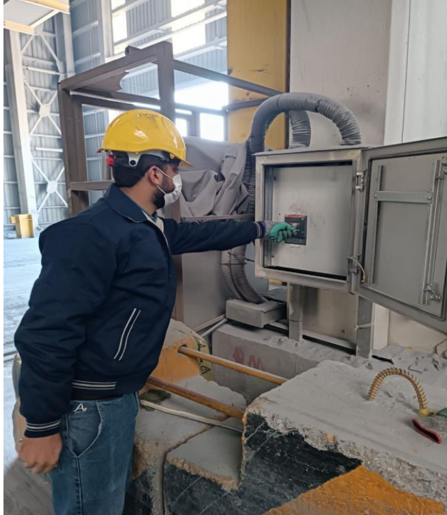
قطع کردن کلید MCCB تابلو شینه های برق ramp
