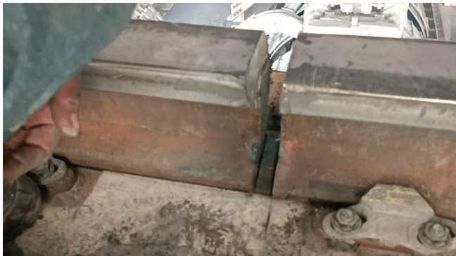
قرار دادن ورق فلزی رو پد لاستیکی زیر ریل
