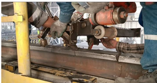
نصب دستگاه برش ریل روی ریل
