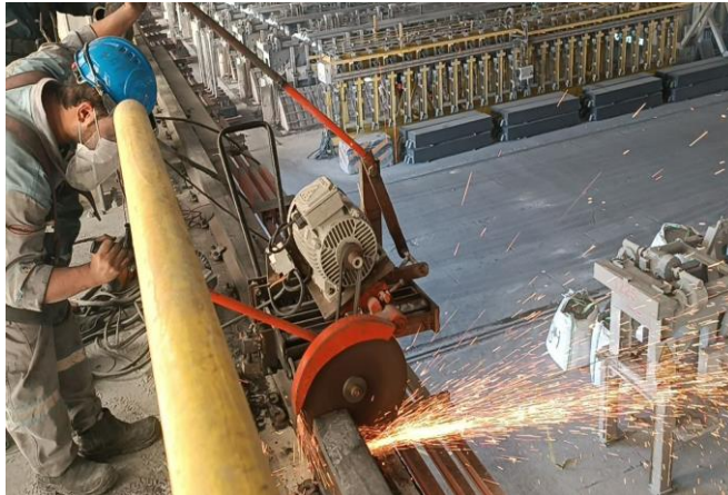
بریدن نقطه اتصال قدیمی و دارای شکاف با دستگاه برش ریل
