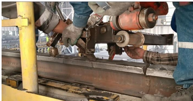
نصب دستگاه برش ریل روی ریل
