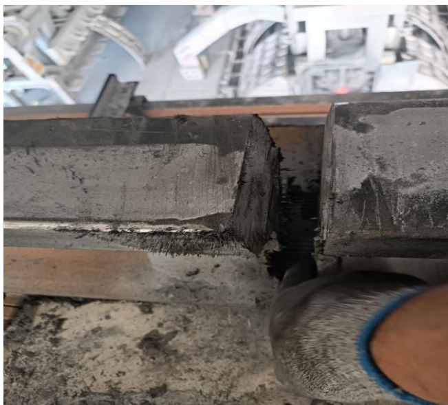
عکس نقطه بریده شده توسط دستگاه برش ریل
