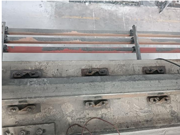
عکس اطراف ریل پس از باز کردن کلمپ ها
