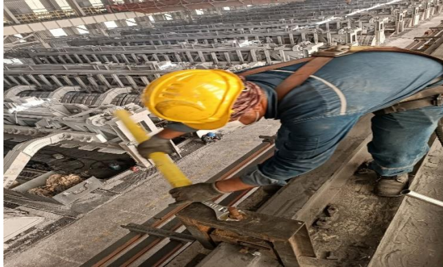
بلند کردن ریل به وسیله جک بالابر ریل
