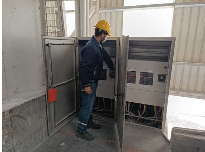
قطع کردن کلید MCCB در تابلوهای محلی
