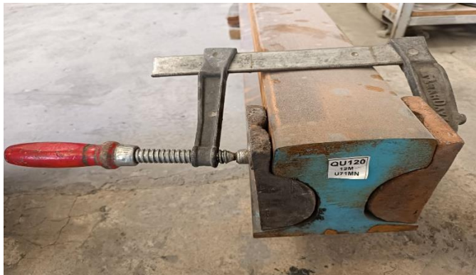
نحوه بستن قالب های مسی روی ریل
